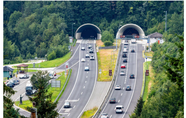
Eine künstliche Intelligenz hilft den Betrieb eines Tunnels noch sicherer zu machen.
